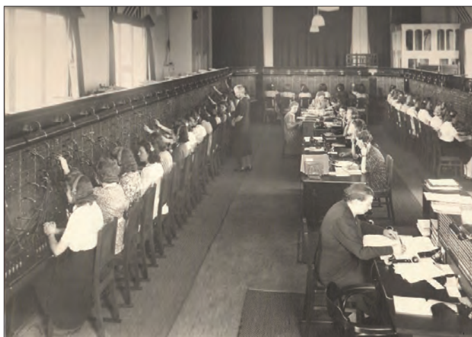
Afb. 9. De telefonistenzaal; achter de toestellen brengen de telefonistes de verbindingen tussen de abonnees handmatig tot stand, 1942. Foto: collectie Museum voor Communicatie.
