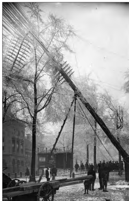
Afb. 3. Een door ijzel bezwaken mast met luchtlijnen op de Spilsluizen noordzijde wordt gestut. Door de grote wirwar aan luchtlijnen zorgde afzetting van ijzel voor extreme lasten, die de houten masten niet konden dragen, 1908. Foto: collectie RHC Groninger Archieven.
