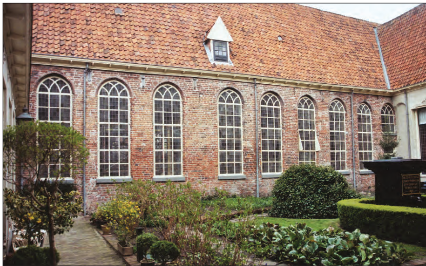
Afb. 16. Peperstraat 20, zuidgevel van de kerk vóór het bepleisteren van het metselwerk in 2008. Foto: Taco Tel, collectie Dienst RO/EZ.
