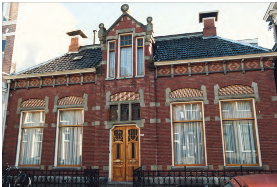
Afb. 19. Marktstraat 12, voorgevel met origineel voegwerk in 1993. Foto: Rita Overbeek, collectie Dienst RO/EZ.
