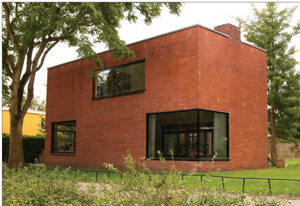
Afb. 18. Goeman Borgesiuslaan 157 na de herstelwerkzaamheden, gezien vanuit het noorden.
