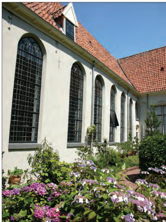
Afb. 26. Pepergasthuis, zuidgevel kerk na herpleistering. Foto: Berend Raangs, collectie Dienst RO/EZ.
