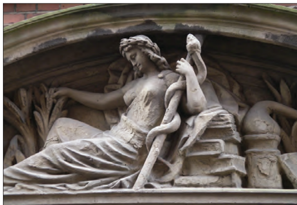
Afb. 8. Broerstraat 9, fronton boven ingang, detail, vóór herstel. Foto: Jurriens, Groningen.
