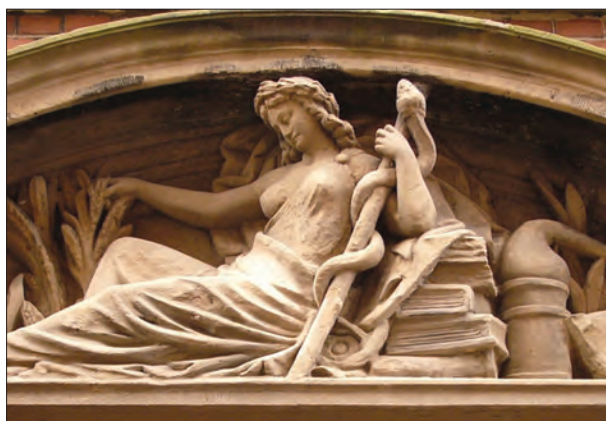
Afb. 9. Broerstraat 9, fronton boven ingang, detail, na herstel. Foto: Berend Raangs, collectie Dienst RO/EZ.
