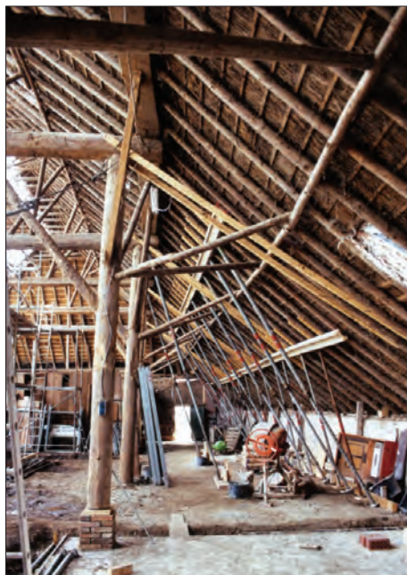
Afb. 9. Noorddijkerweg 32. Hulpconstructie om de gebinten in de hoofdschuur weer terug te duwen. Ook kwam hierdoor de rechterzijgevel weer rechtop te staan.
