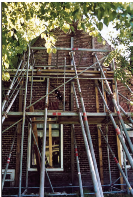
Afb. 8. Noorddijkerweg 32. De hulpconstructie om de voorgevel, die 69 cm uit het lood stond, weer terug te duwen.
