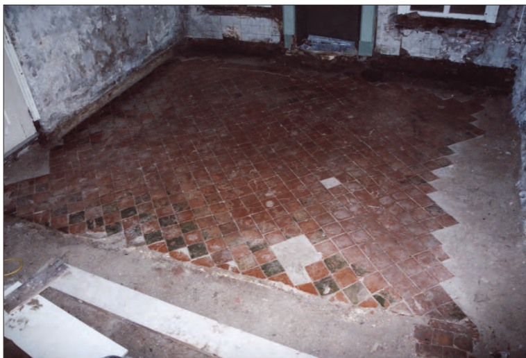
Afb. 5. De 17e-eeuwse plavuizenvloer in 2006 na verwijdering van de latere vloeren die hieroverheen waren aangebracht. Foto: Taco Tel, collectie Dienst RO/EZ.
