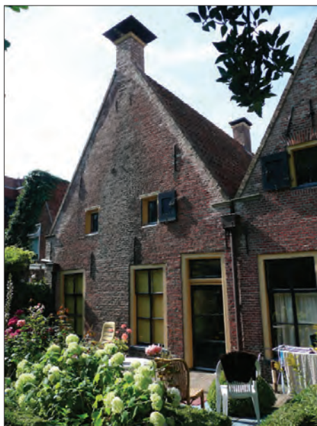
Afb. 11. Achtergevel van het rechter bouwdeel, ge fotografeerd vanuit de tuin. Foto: Taco Tel, collectie Dienst RO/EZ.
