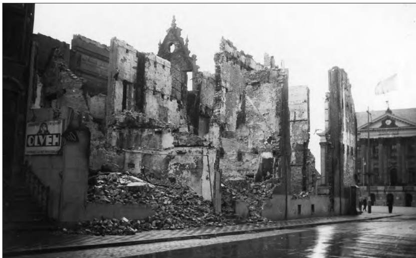
Afb. 15. De ruïnes aan de oostzijde van de Grote Markt, gezien vanaf het Martinikerkhof. De constructie van de geveltop van de Herensociëteit alias huis Panser is op deze foto herkenbaar: de beeldhouwde natuurstenen platen met het leeuwte in top steunen tegen de van bakstenen gemetselde puntgevel.
