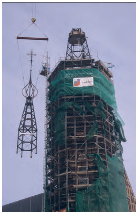
Afb. 6. De restauratie van de Jozefkerk in volle gang.
