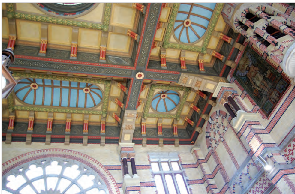
Afb. 8. Het herstelde plafond van het stationsgebouw in 2009. Foto: Claudia Versloot, collectie Dienst RO/EZ.
