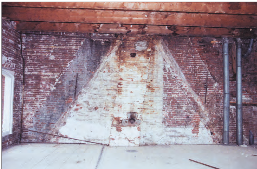
Afb. 24. Oude Kijk in 't Jatstraat 20, de zolder gezien naar het zuiden. Duidelijk zichtbaar is de vroegere geveltop van het huis (wit gepleisterde driehoek). De stroken daarboven horen bij het linker buurpand (Oude Kijk in 't Jatstraat 18) terwijl de driehoekige stukken metselwerk daar weer boven horen bij de laat-19e-eeuwse op-hoging van Oude Kijk in 't Jatstraat 20. Foto: Taco Tel, collectie Dienst RO/EZ.
