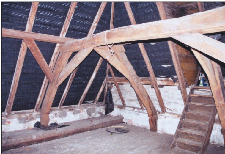
Afb. 13. Herestraat 67, de kapconstructie in het zuidelijke deel van het achterhuis. Aan de kopse enden zijn de oude gebinten verzaagd tot halfspanten en voor de tweede keer herplaatst. Foto: Taco Tel, collectie Dienst RO/EZ.
