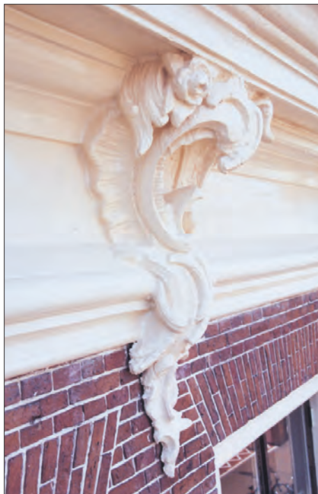
Afb. 16. Oosterstraat 29, detailfoto van een van de rocococonsoles.
