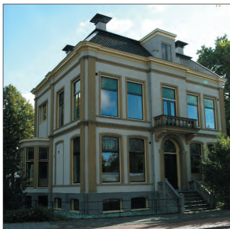
Afb. 32. Zuiderpark 26 na herstel.
