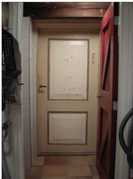
Afb. 9. De herplaatste deur in de boerderij Rijksweg 14.
