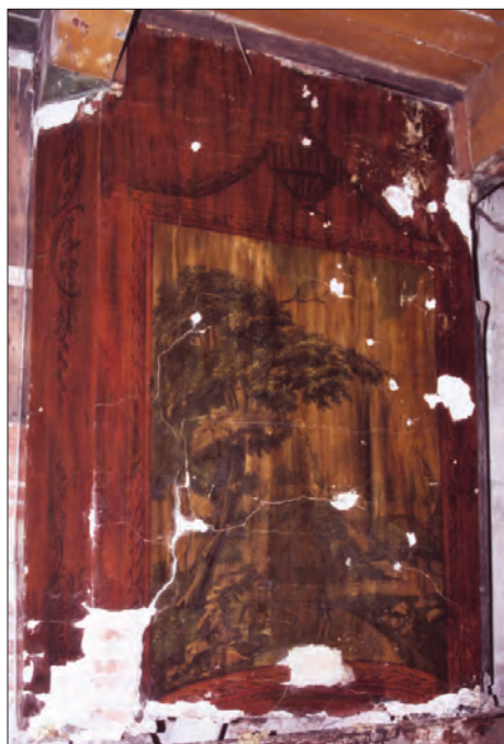
Afb 4. Schoorsteenboezem met mahonie-imitatie en schoorsteenstuk.
