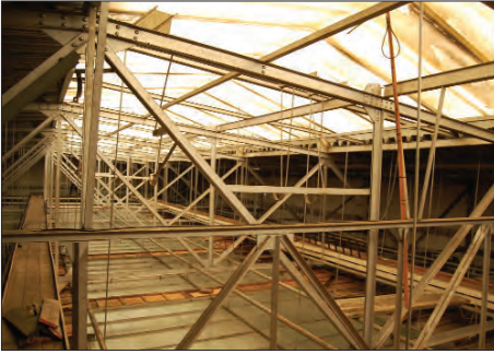
Afb. 32. Overzicht van de kapconstructie van het ketelhuis (1921), bestaande uit stalen vakwerkspanen. Op deze foto zijn de lichtkap en de bovenlichten in het plafond van de theaterzaal zichtbaar.
