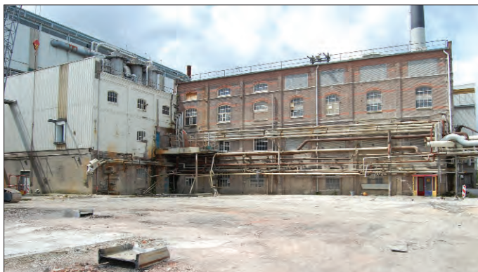
Afb. 27. Overzicht van de oostgevel van het voormalige kalkgebouw, na verwijdering van bijgebouwen en leidingen (juni 2009). Foto: Jan van der Hoeve, Utrecht.
