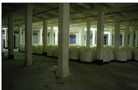
Afb. 38. Betonconstructie met betonnen tussenvloer op de begane grond van het oude entrepotgebouw (1921).
