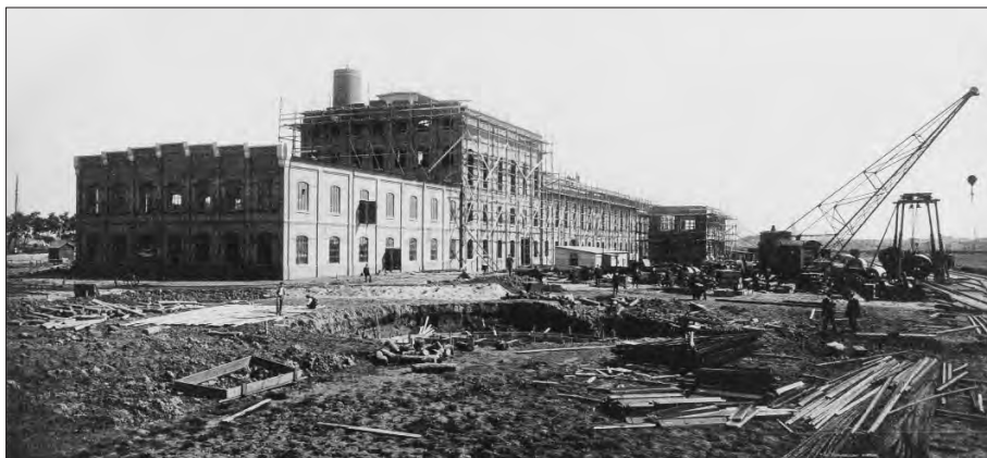
Afb. 4. Overzicht van de zuidgevel van de fabriek tijdens de bouw in 1914. Van Links naar rechts: het tweelaagse suikerpakhuis (D), het hoge suikerhuis (C) en het tweelaagse voorgebouw (B). Rechts voor het gebouw is het kantoorgebouw zichtbaar. Foto: collectie RHC Groninger Archieven inv.nr. 818-5044.
