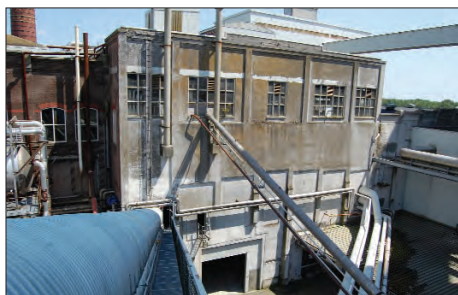
Afb. 25. Westgevel van het suikerpakhuis. Het onderste deel uit 1915 heeft klimmende spaarvelden, die een restant zijn van de oorspronkelijke architectuur. Het bovenste deel stamt uit 1958-'59.
