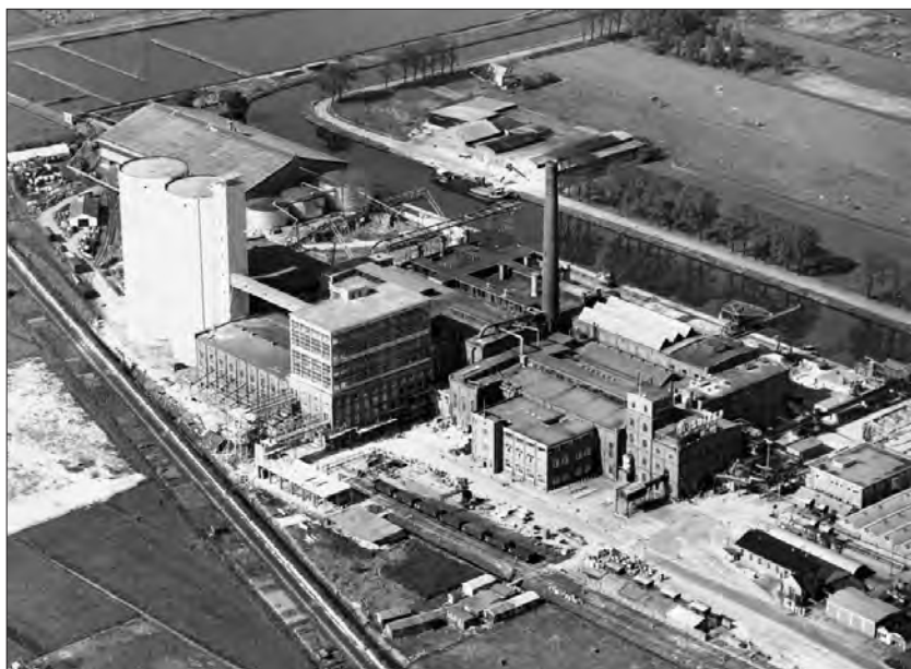
Afb. 13. Luchtfoto van de suikerfabriek in 1960. Men is bezig met de bouw van het zeefgebouw, de beide betonnen silo's en de looppbrug met een suikertransportband. De Jonge 2008, p. 29.
