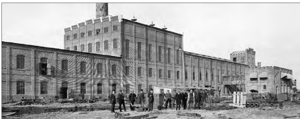
Afb. 23. Overzicht van de zuidgevel van de zuidvleugel, tijdens de bouw in 1914. Het hoge suikerhuis domineert het beeld. De Jonge 2008, p. 4-5.
