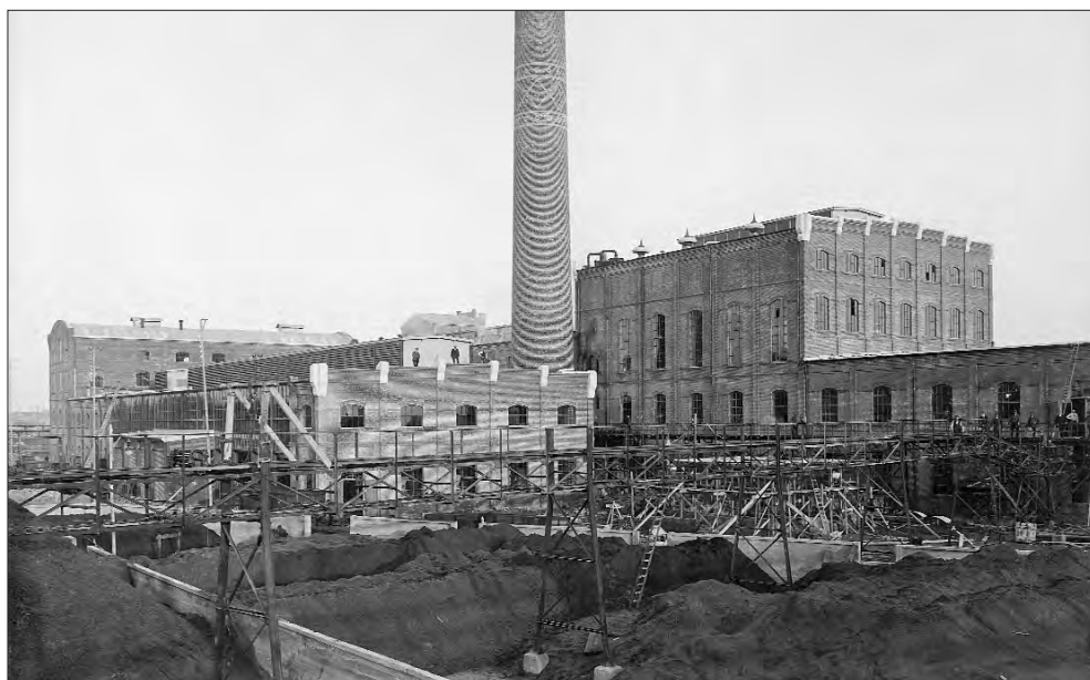
Afb. 5. Overzicht van het ketelhuis, vlak na de bouw in 1914. De langsgevels van het toen nog relatief lage ketelhuis zijn uitgevoerd in stalen vakwerk met baksteen invullingen. Het achterste deel heeft bakstenen gevels met pilasters, zoals de overige gebouwen (laboratorium en pomplokaal). De kopgevel heeft dezelfde markante architectuur als de overige gebouwen. De Jonge 2008, p. 12-13.
