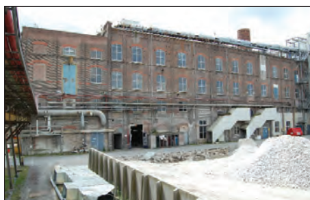
Afb. 29. De noordgevel van het voormalige kalkgebouw (de drie linker traveeën) uit 1914 en van het ketelhuis. Dit deel van de gevel van het ketelhuis stamt grotendeels uit 1921. Foto's: Jan van der Hoeve, Utrecht.
