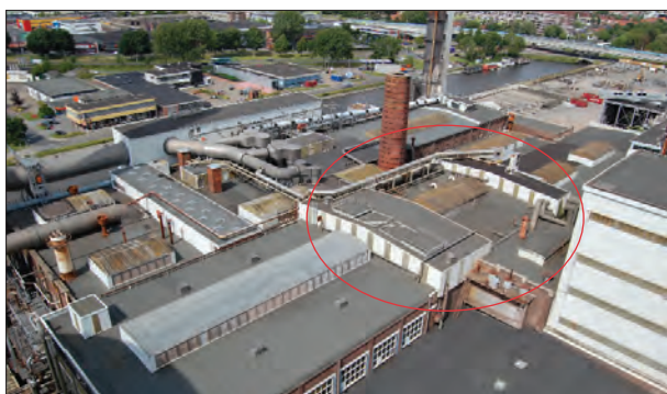
Afb. 24. Het oude suikerhuis is tegenwoordig geheel omgeven door hoge bebouwing. De beide kopgevels worden gemarkeerd door hogere opbouwen. Het dak heeft een verhoogde lantaarn. Foto: Jan van der Hoeve, Utrecht.
