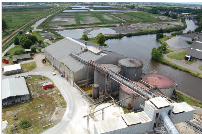
Afb. 40. Overzicht van de pulploods, gezien vanaf de westelijke silo. Naast deze loods is het Hoendiep zichtbaar, dat hier een haakse bocht maakt. Op de achtergrond zijn de vloeivelden zichtbaar.
