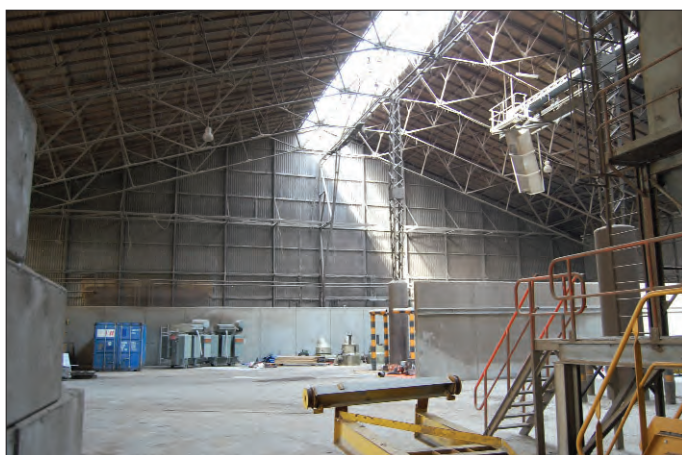
Afb. 41. Overzicht van de constructie van de pulploods. Foto's: Jan van der Hoeve, Utrecht.
