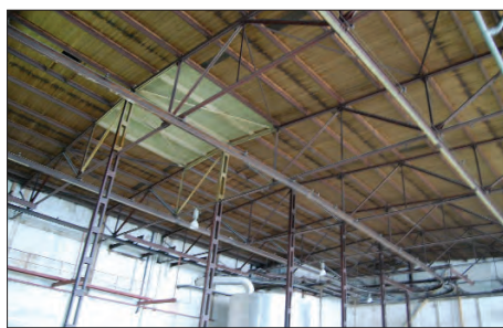
Afb. 39. Staalconstructie op de verdieping van het oude entrepotgebouw. Bij de verhoging van dit gebouw in 1921 is de bestaande constructie uit 1915 herplaatst. Foto's: Jan van der Hoeve, Utrecht.
