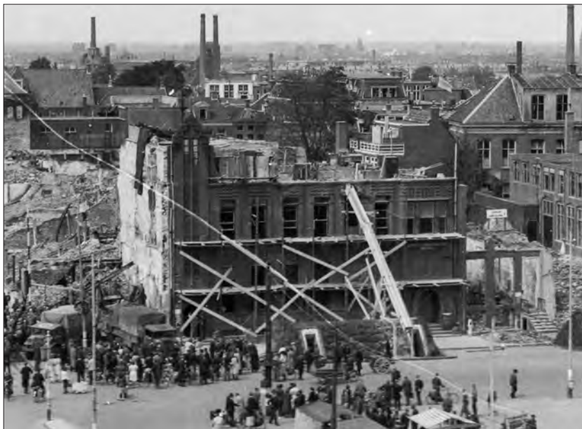
Afb. 2. Herstelwerkzaamheden aan het gebouw van de Amsterdamsche Bank, 1945. Fotograaf onbekend, collectie: RHC Groninger Archieven, inv.nr. 1785-23242.
