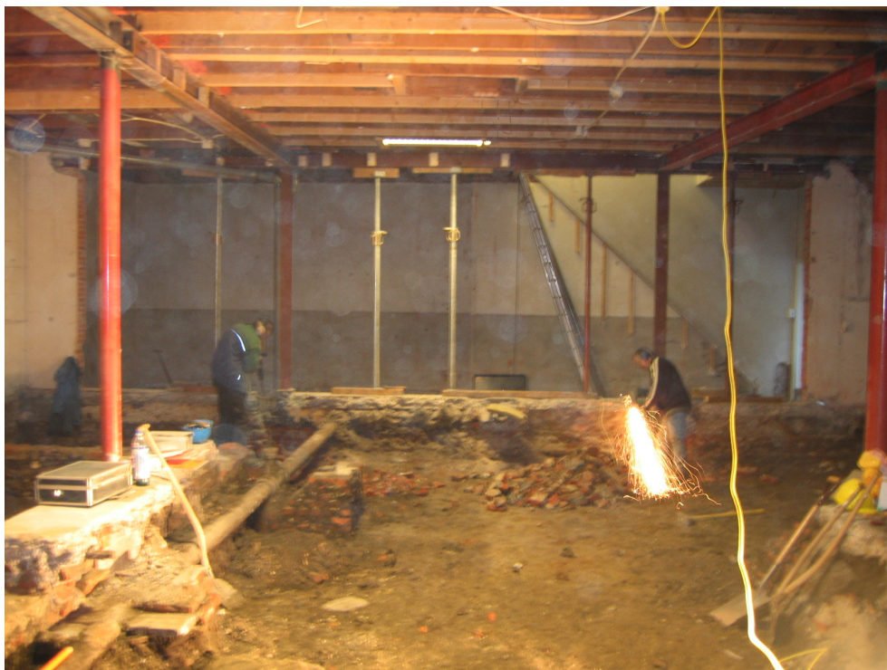
Afb. 3. Tijdens de opgraving werden de bouwwerkzaamheden in de werkput niet gestaakt.
