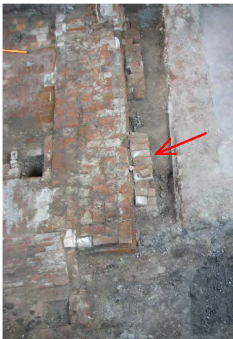
Afb 9.1 Bovenste laag van de zuidelijke fundering van huis Panzer met in kettingverband bakstenen waartussen dun kistwerk was aangebracht. Rechts van de fundering liggen in de osendrup enkele bakstenen die de fundering waren van de 17 e eeuwse aanklamping (zie rode pijl) (foto richting oosten genomen). Foto: R.F. Kruisman
