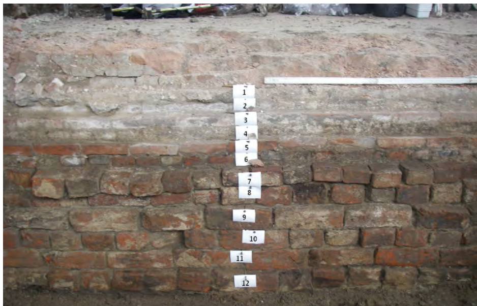
Afb. 9.4 Fundering Scholtenhuis met verschillende maten (her)gebruikte bakstenen (foto richting het zuiden genomen). Foto: B.P. Tuin
