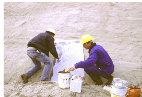
Opbrengen van een 'gaasrug' op het lakprofiel 4, (dit ter versteviging van het profiel)
