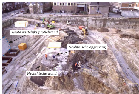
Overzichtsfoto van de bouwput op het AZG terrein
