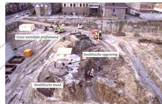
Overzichtsfoto van de bouwput op het AZG terrein
