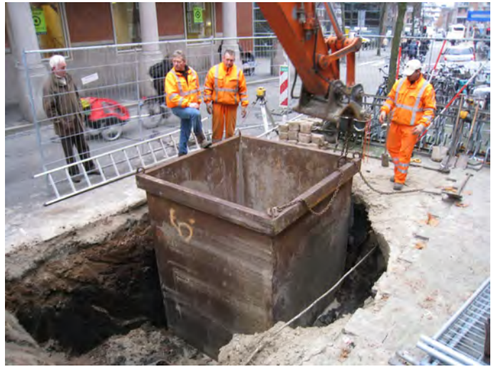
Afbeelding 9: Plaatsing van het eerste container(werk)frame in werkput 1, gezien naar het noordoosten. Foto: B.P. Tuin.
